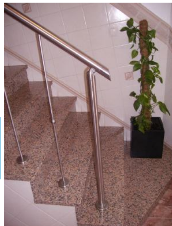
Curva final 42,4 em 316 acabamento esférico
