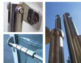
Spray de limpeza básico de aço inoxidável em superfícies sujas Pulverize, deixe fazer efeito e use um pano limpo Faça um polimento completo do pano na direção do lixamento. Por causa do Se o teor de sólidos for alto, a lata deverá ser limpa antes de cada processo de pulverização ser bem agitado, por períodos mais longos Processos de pulverização também intermediários. Recomendação: Após a limpeza básica, a área com Metaflux 70-55 Proteja o spray de cuidado de aço inoxidável.
